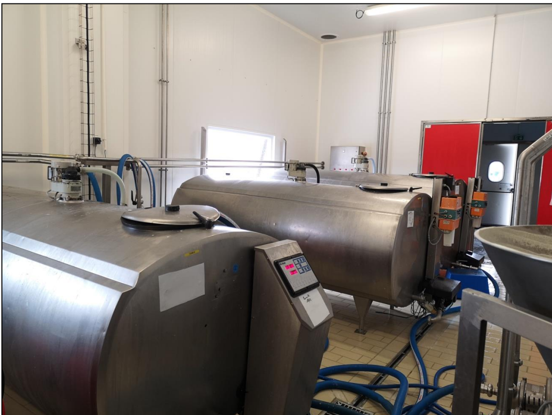
Tank à lait/arrivée du lait depuis la stabulation :
